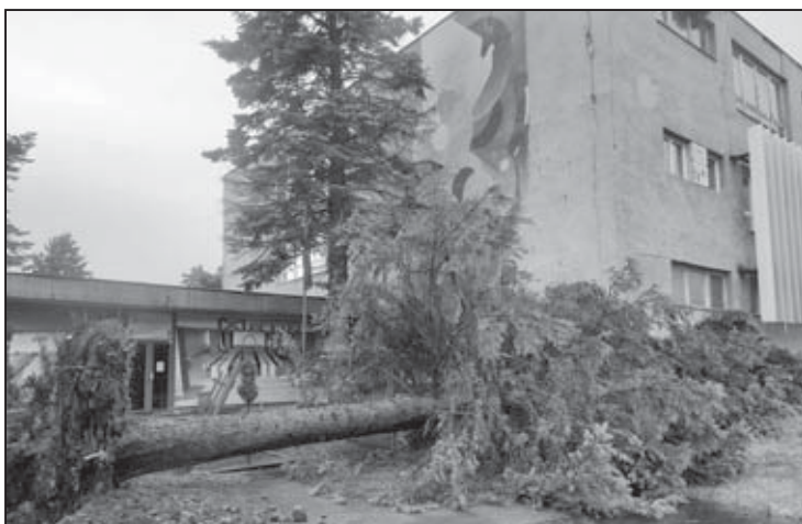
V areáli pri Reštaurácii Martin vo Svidníku spadnutý strom zatarasil vstup. Časť stromu po silnom vetre skončila až na streche budovy.
