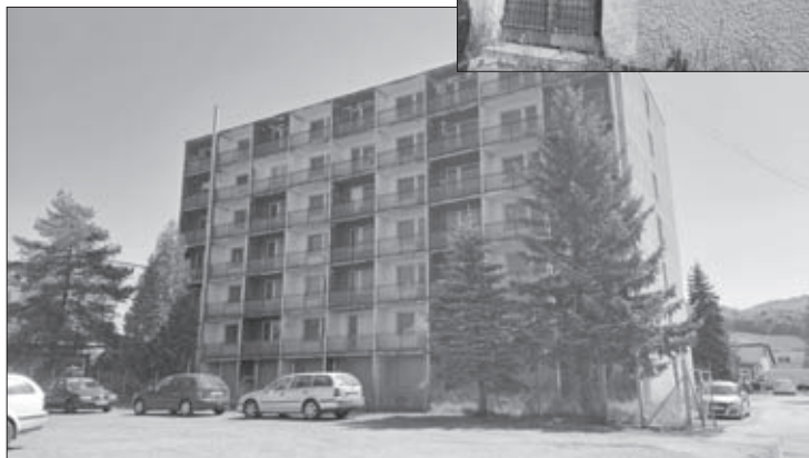
Rekonštrukciou ubytovne mesta Svidník na nájomné bývanie by malo vzniknúť 45 2-izbových bytov a šesť 3-izbových bytov
