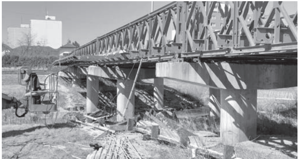
Takto by už mali robotníci začať rozoberať aj lávku pre peších na druhej strane mosta. Kedy sprístupnia prvú, ktorá je už osadená, zatiaľ nevedno
